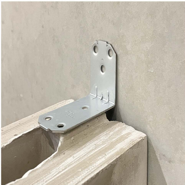
特製鍍鋅加厚L型鐵件補強
