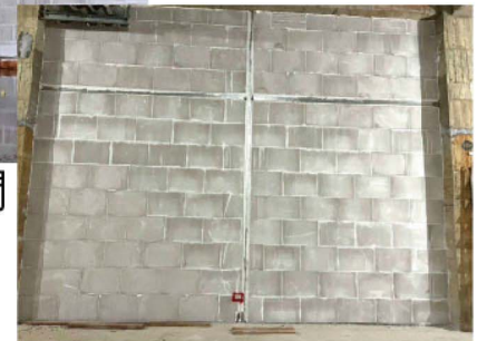
挑高六米以上結構柱補強施工
