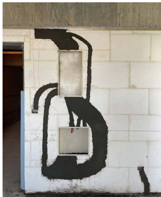
水泥砂漿管路回填
