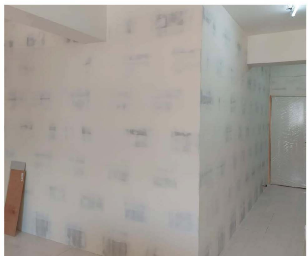
批土工法2 (使用市售三陽/雙喜批土，須先接縫處進行兩道批土，再全牆面透批兩道，即可打磨上漆)
