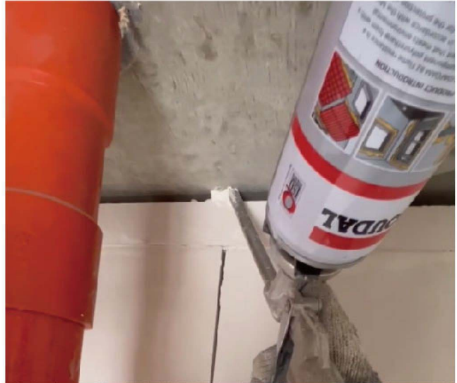
使用B2阻燃型發泡劑或水泥砂漿填縫
