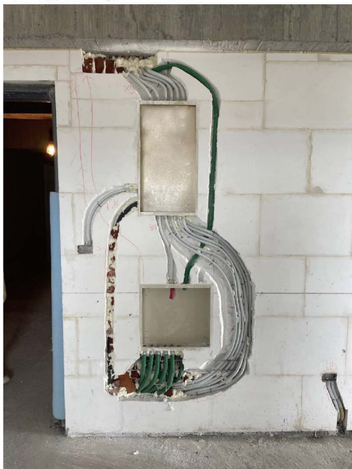
水電切管溝配電工程(需先劃線放樣再切管溝)
