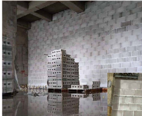
大型建案挑高隔間
